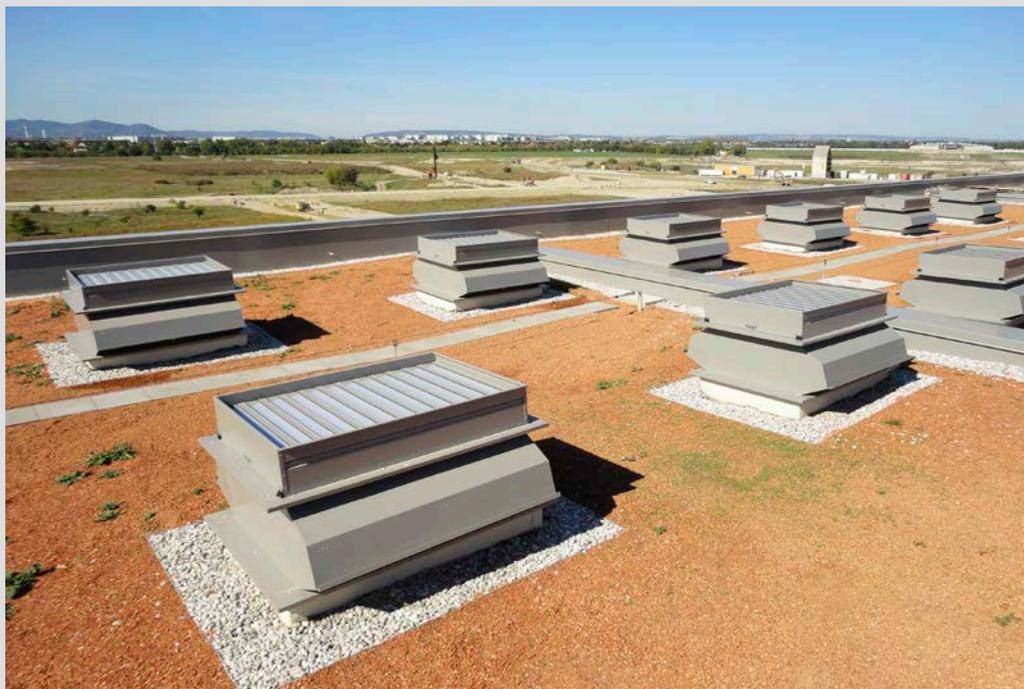
152 Rauch- und Wärmeabzugssysteme vom Typ EuroCO mit Weatherlite Sockelsystemen sorgen in der Abstell- und Revisionshalle für gute Luftkonditionen und Sicherheit im Brandfall
