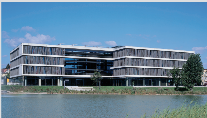
▲ Fast die komplette Fassade ist mit den asymmetrisch angeordneten Rohrlamellen bestückt.
