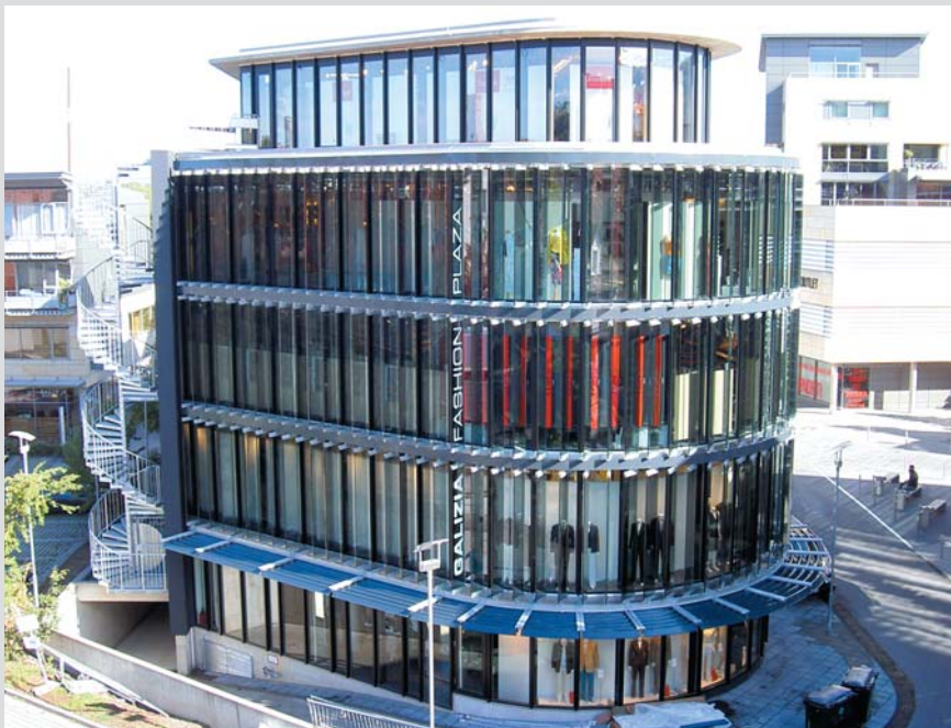
Automatisch gesteuertes, 494 m 2 großes Lamellensystem
