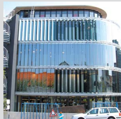
Die komplette Fassade besteht aus vertikal angeordneten Glaslamellen
