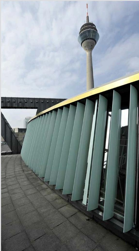
Die Architekten, das Büro Eller & Eller aus Düsseldorf, konzipierten für das Landtagsgebäude am Rheinknie in Düsseldorf zusammen mit dem Fachplanungsunternehmen Drees & Sommer aus Stuttgart eine neue, außen liegende, maßgeschneiderte Lamellenanlage, die sich in die Dachkonstruktion des Plenarsaales einfügt. Als Partner für Bau und Installation der Lamellenanlage hat sich in einem öffentlichen Wettbewerb Colt durchgesetzt.
