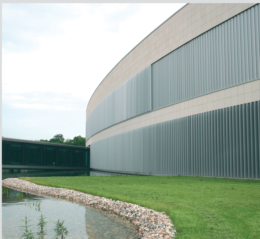
Vertikale, geschosshohe Lamellen prägen das Gesamtbild der Fassade
