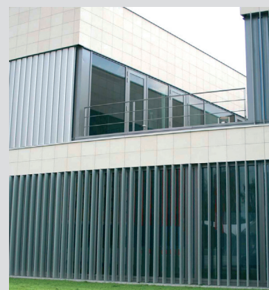
Die vertikalen Lamellen werden dem Sonnenstand nachgeführt
