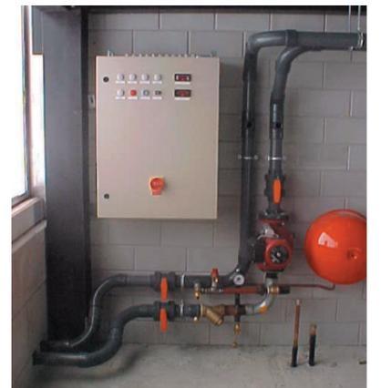
Wasserkreislauf mit einzelnen Pumpen, Expansionsgefäß und einem zentralen Schaltschrank.
