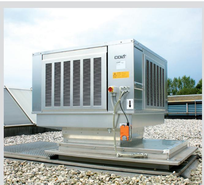
Der Colt CoolStream ist ein natürliches Kühlsystem, dessen Konzept auf Luftabkühlung durch direkte Verdunstung von Wasser basiert. Investitions- und Betriebskosten der Verdunstungskühlung sind wesentlich günstiger als bei herkömmlichen Systemen. Eine Kombination mit ColtAir ermöglicht einen energieeffizienten Ganzjahresbetrieb – eine Steuerung für das komplette System ist gleich inklusive. So wird Geld gespart, die Zukunft gesichert und das Klima geschützt.
